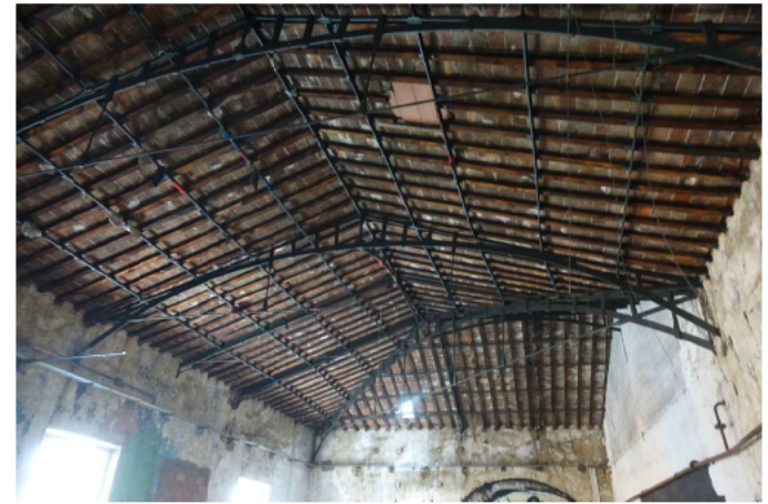
F06. ESTRUCTURA COBERTES
